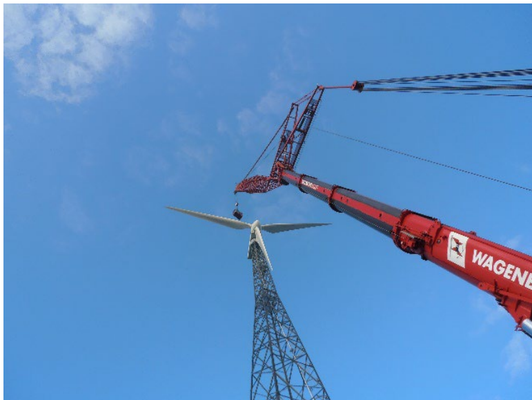
2014 Desmantelamiento de 4 turbinas Vestas V47 Hamburg - Alemania
